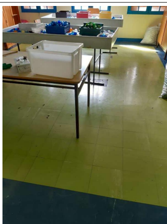
Déclaré - : RDC EXTERNAT / ESCALIER - Dalle de sol - EP- (Présence d'amiante)
